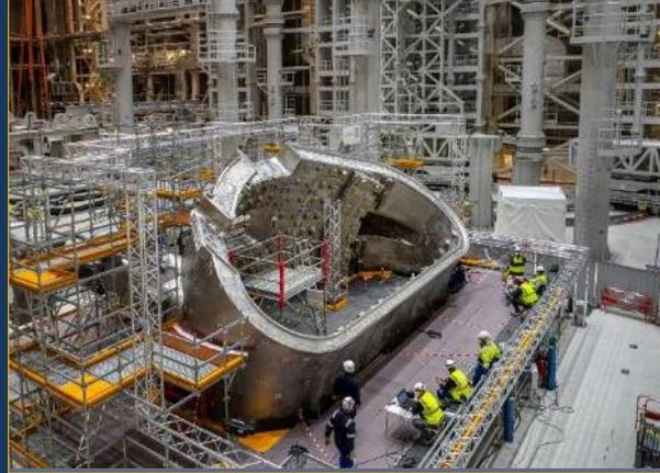
Le secteur de chambre à vide # 6, fourni par la Corée et livré début août 2020, sera accouplé aux bobines de champ toroidal #12 et #13 et à la section d'écran thermique correspondante pour former le premier « pré-assemblage ».
